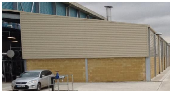
(3) BIOFILTRO PER ABBATTERE GLI ODORI DEL PROCESSO
