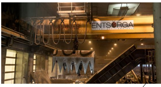
(4) CARROPONTE AUTOMATICO PER SPOSTARE IL MATERIALE
