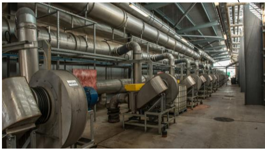
(2) SISTEMA DI VENTILAZIONE PER ESTRARRE L'ARIA ESAUSTA
